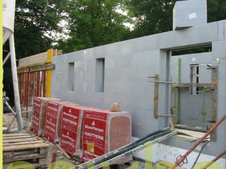
61_Schalung des Garagensturzes
