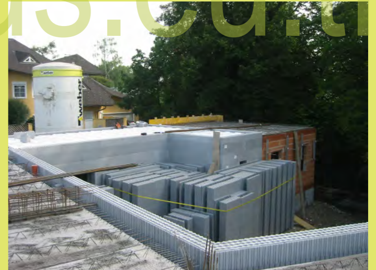
77_Die Garagenplatten sind verlegt
