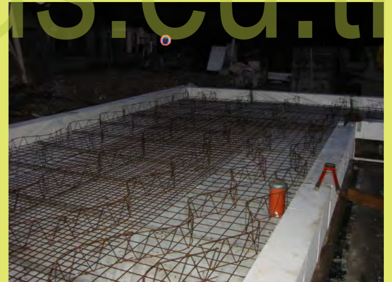
35_Folie und Bewehrung
