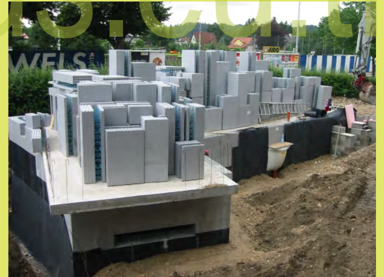
12_Hinterfüllen des Kellers
