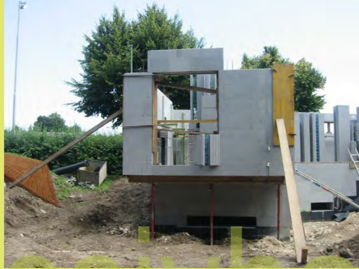
43_Abstützung zum betonieren
