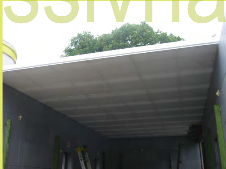
70_Decke des Nebengebäudes
