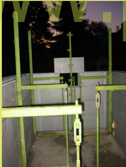
57_Richtstützen im NG montiert
