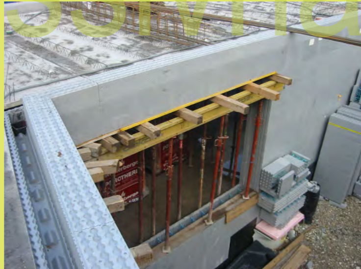
82_Die Sturzsäule ist montiert
