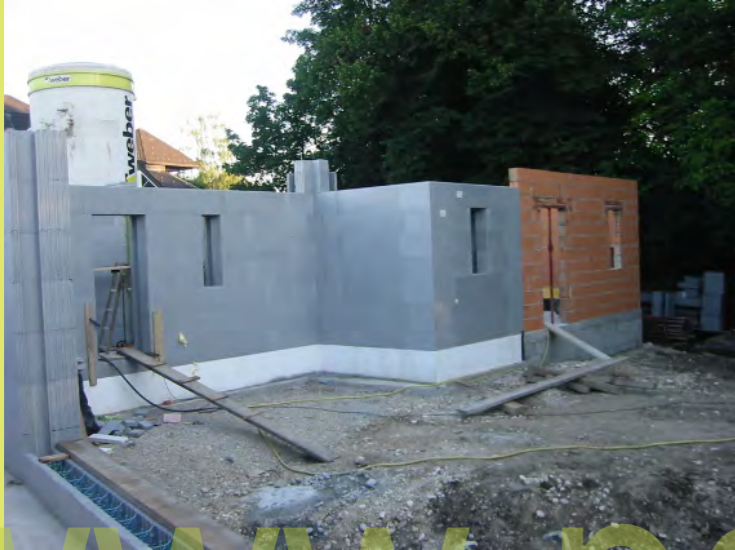
60_Die Garage ist aufgemauert
