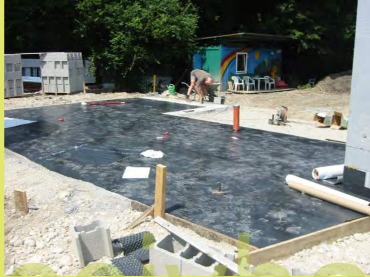
32_Fertig für die Bodenplatte
