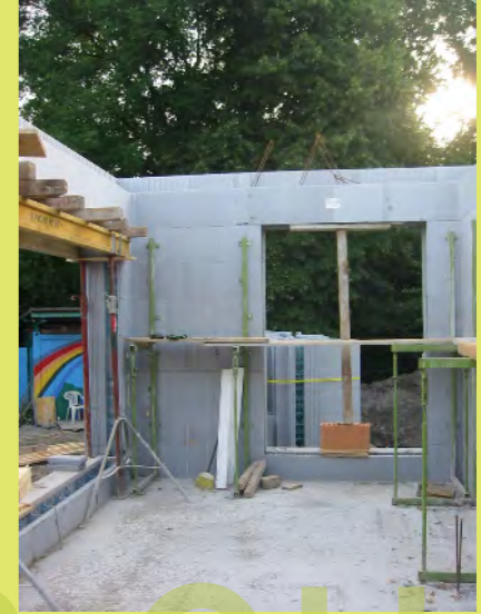
68_Stütze für den Beton
