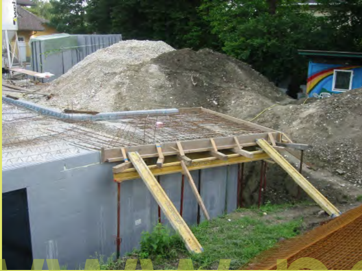
01_Deckenplatten sind verlegt
