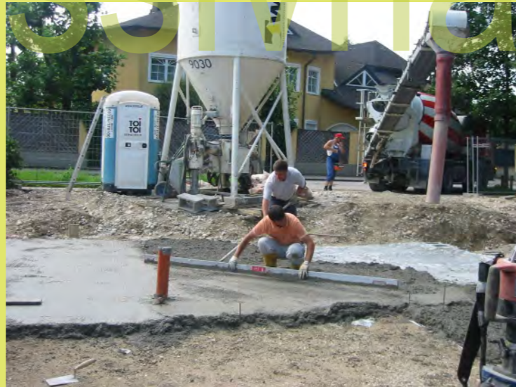
29_Sauberkeitsschicht für das Nebengebäude
