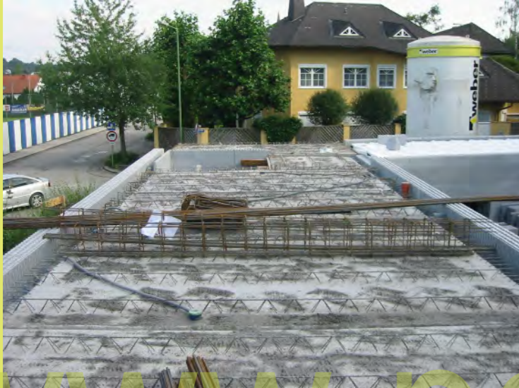
78_Die EG Deckenplatten sind verlegt
