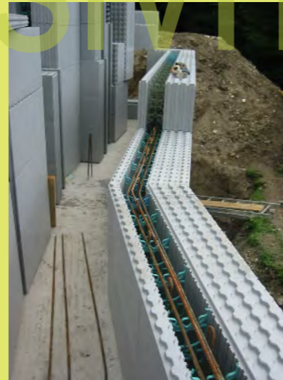
17_Bewehrung der Auskragung
