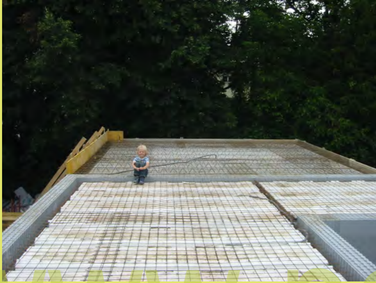
90_Elias bei der Inspektion
