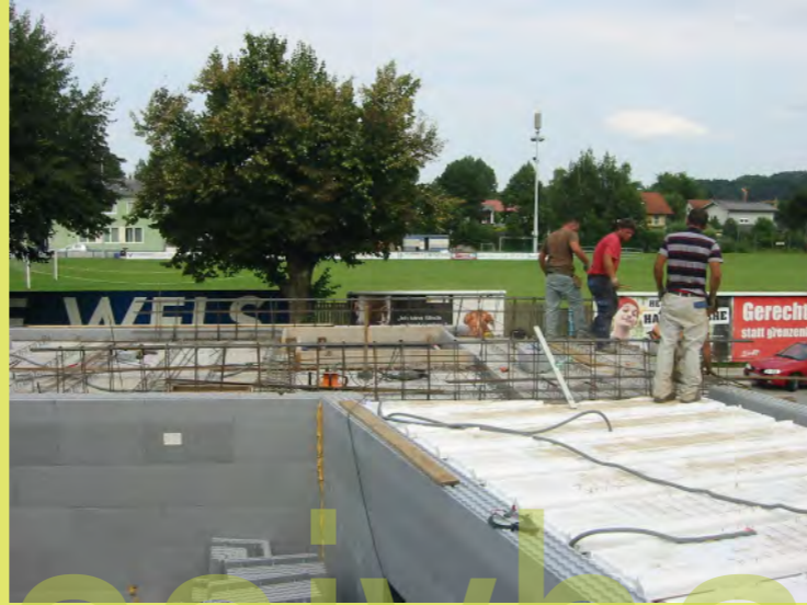
85_Die Bewehrungsträger für die Auskragung
