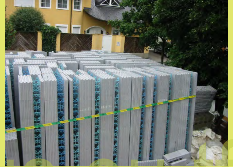
09_Die warten bis der Beton trocknet
