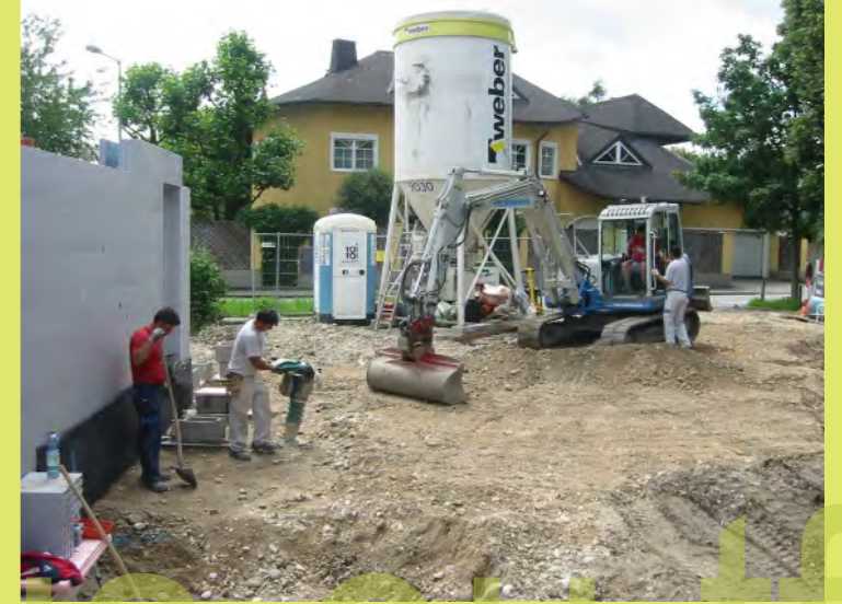
21_Der Unterbau für das Fundament
