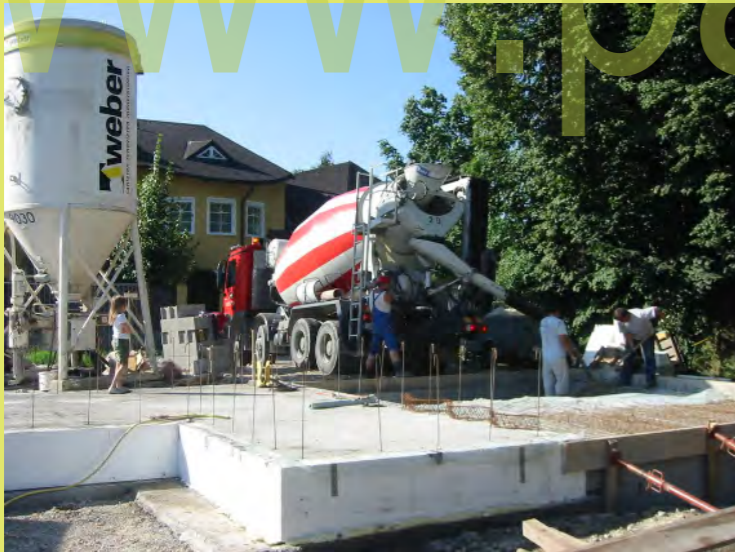
45_Bodenplatte der Garage
