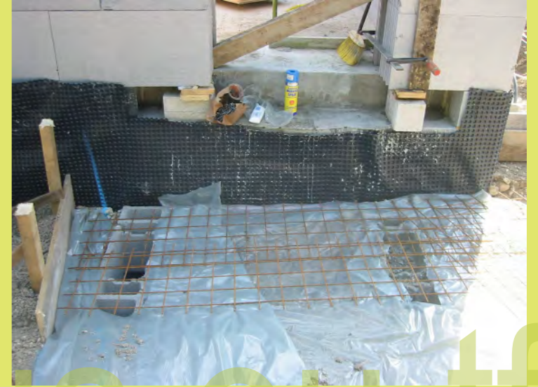
27_Bewehrung beim Gebäudeanschluss
