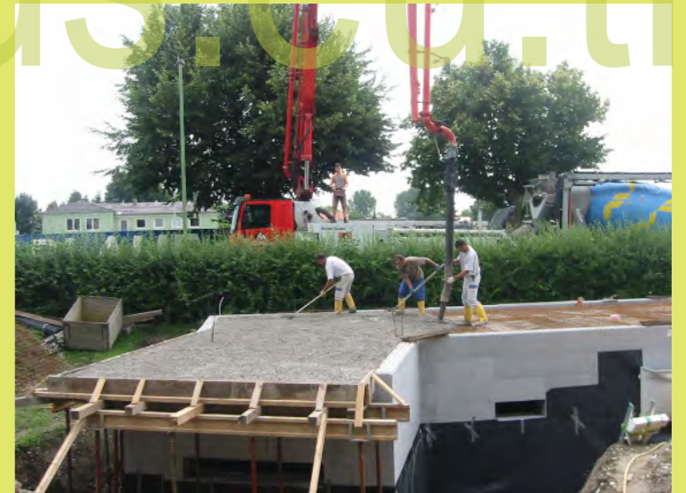
06_Endlich wieder Beton
