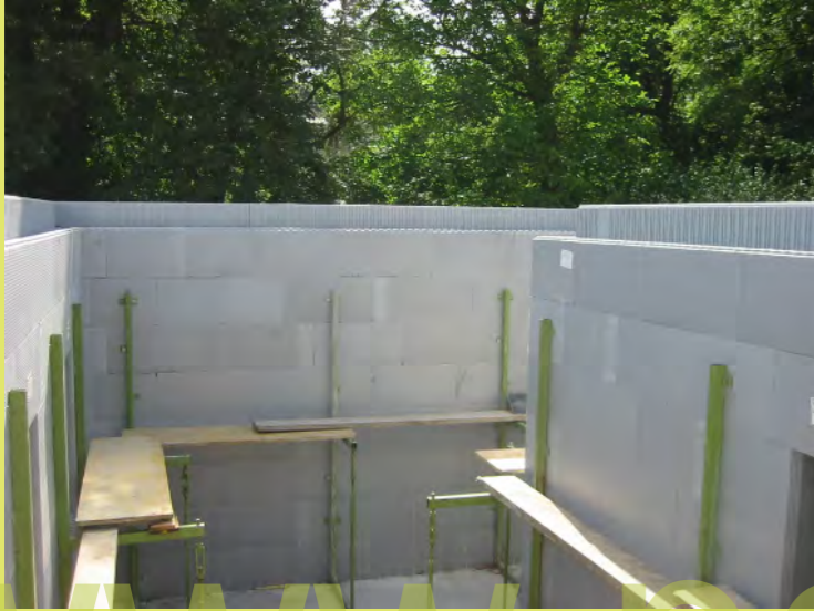
66_Richtstützen als Gerüst
