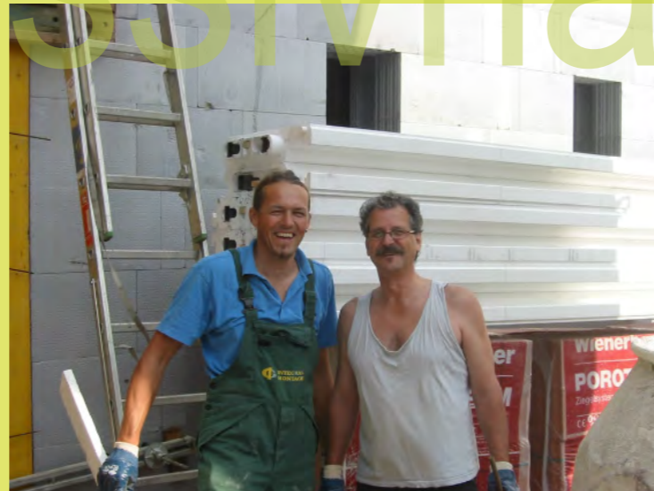
28_Fernando von PH3000 hilft beim Decke verlegen
