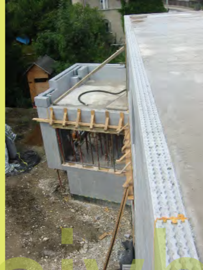
40_Weiter gehts mit dem Stecken der Attika
