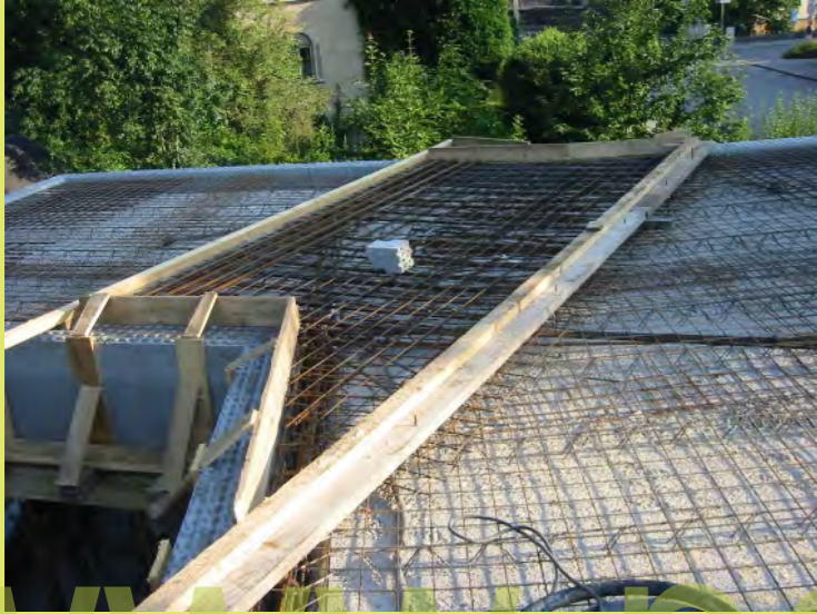
01_Bewehrungsträger über der Fensterfront
