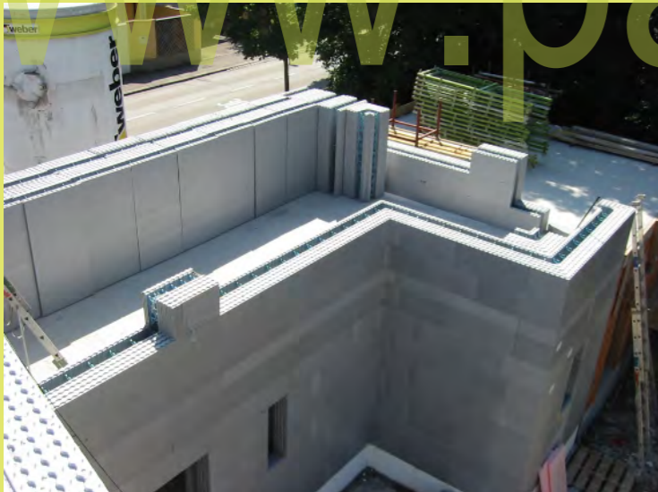
42_Dann das restliche Material rauf
