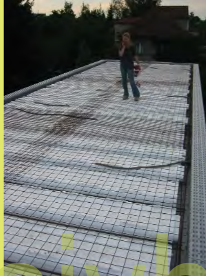
36_Decke bewehrt und E-Installation
