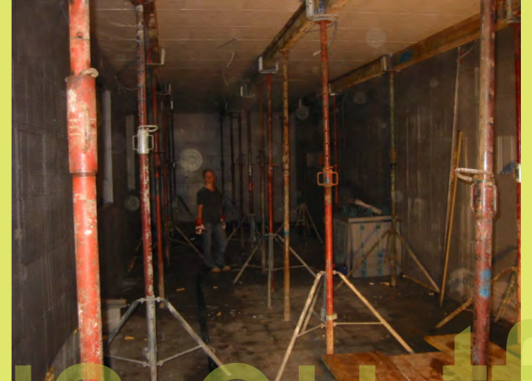
36_Unterstellung noch einmal gecheckt
