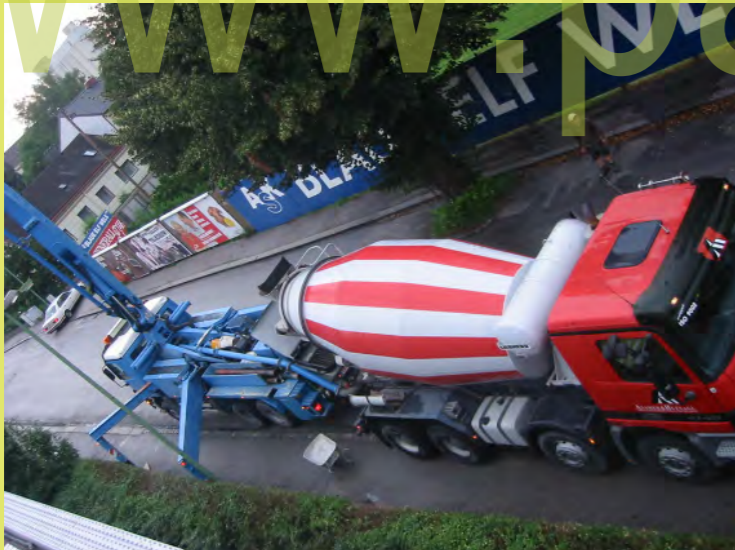
37_Die Griesstrasse ist halbseitig gesperrt
