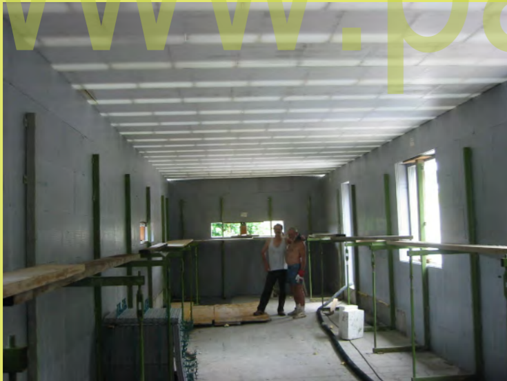
32_In 2 Stunden hinauf gehoben und verlegt
