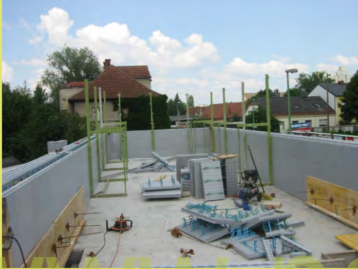
13_Die Bewehrungsträger sind abgeschalt
