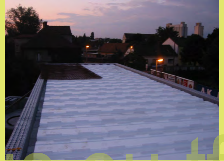
32_Der Baustahl für die Deckenbewehrung
