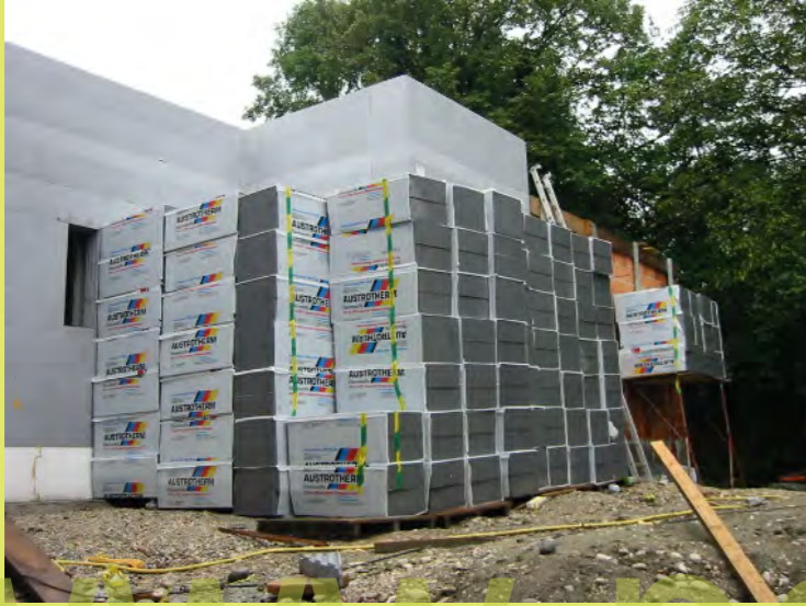
50_Neopor-Dämmstoff für die Attika
