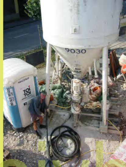
45_Das letzte mal Silo-betonieren
