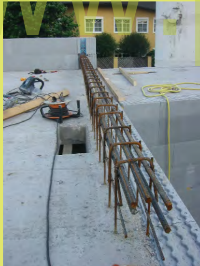
10_Die werden dann im Betonkern verschwinden
