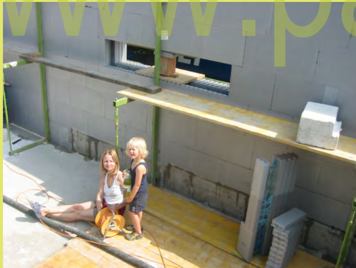
21_Pezi + Elias steuern die Betonpumpe
