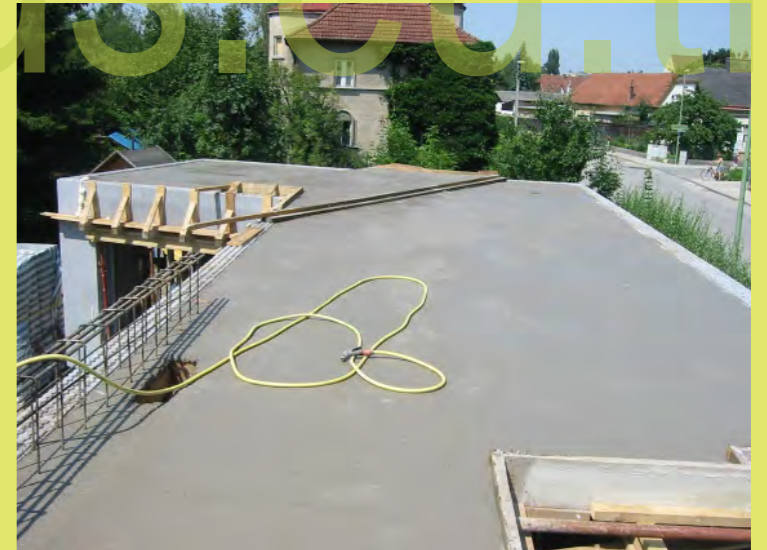
06_Die Bewehrungsseisen der Auskragung
