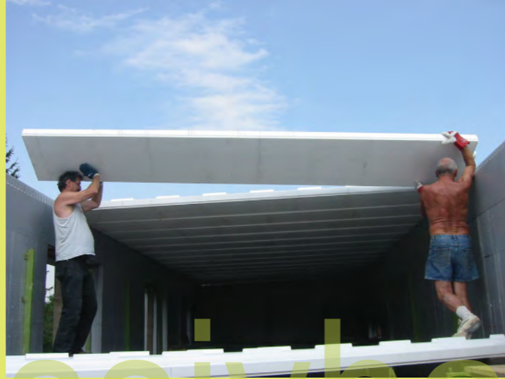
31_WTM-Decken legen ist keine Schwerstarbeit
