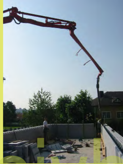
14_Zwecks Statik kommt Spezialbeton
