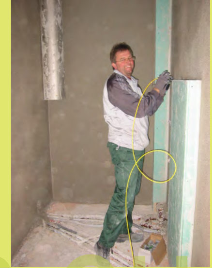
51_Bert hilft beim Kabel einziehen
