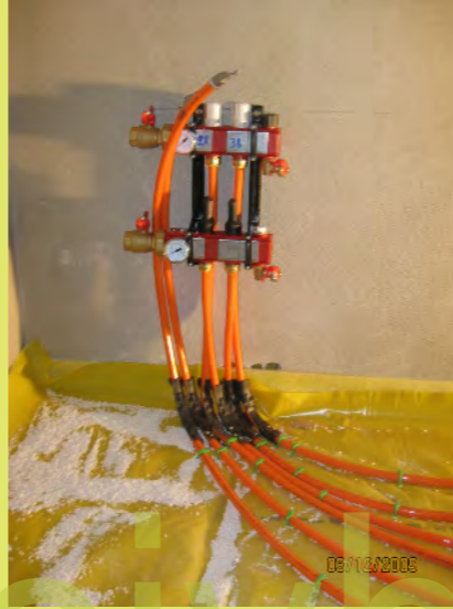
08_Der Kellerverteiler
