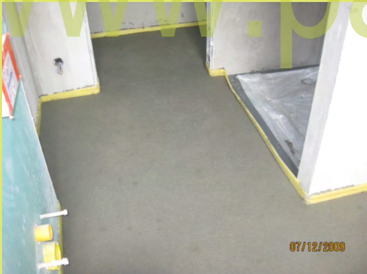
16_Die ersten Schritte am neuen Estrich
