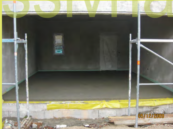
11_Der Estrich liegt - hier die Garage
