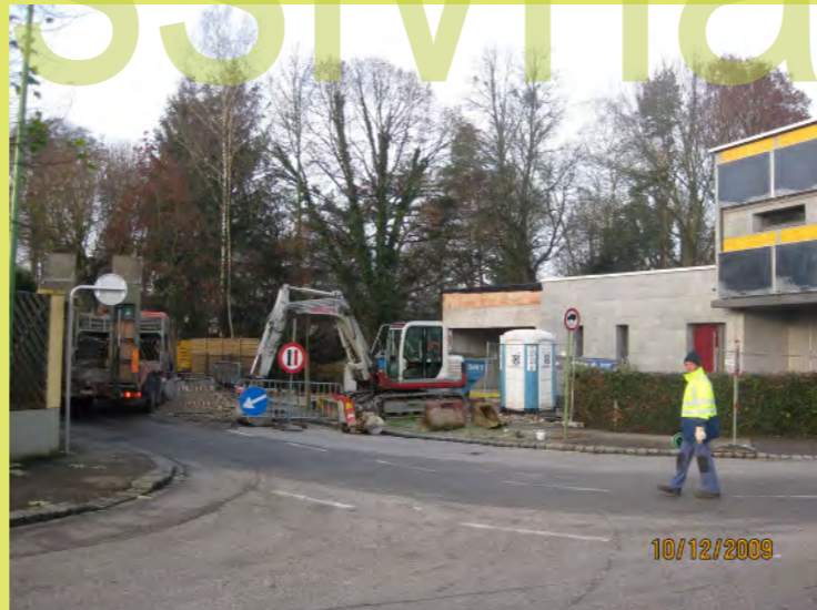
23_Das E-Werk legt den Kanal auf das Grundstück
