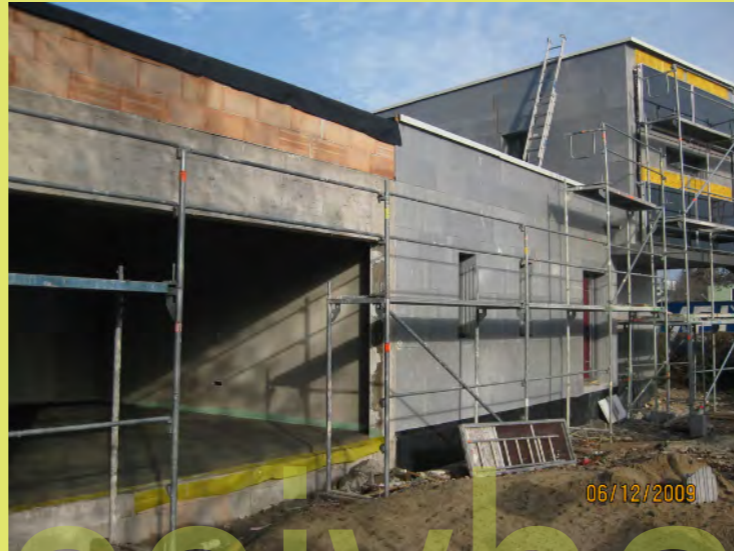
14_Nikolausstimmung auf der Baustelle
