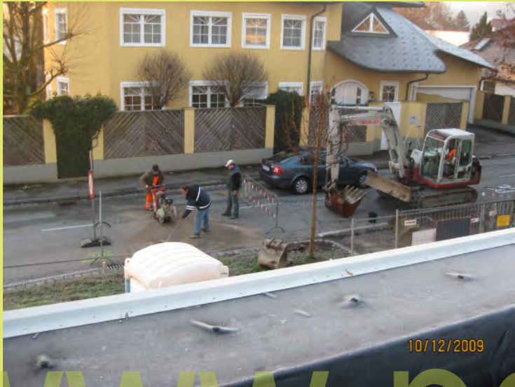
25_Die Strasse musste halbseitig gesperrt werden
