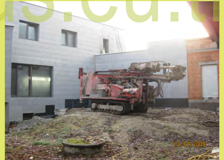
24_Und die Bohrfirma macht die Tiefenbohrung
