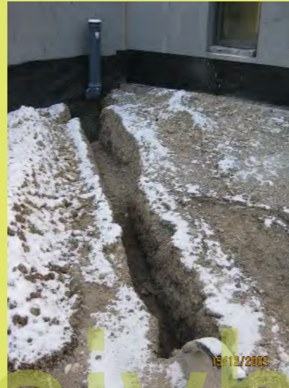
26_Vor dem Frost habe ich noch die K nette gegraben
