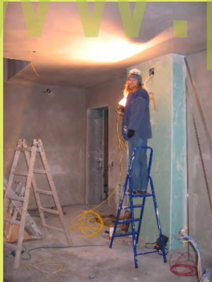
04_Pezi hilft beim Kabeleinziehen
