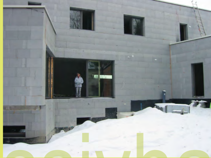
24_Eine kompakte Schneedecke hüllt die Baustelle ein
