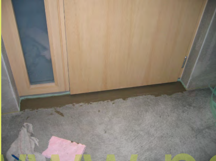
01_Niveauegleich an den Türen
