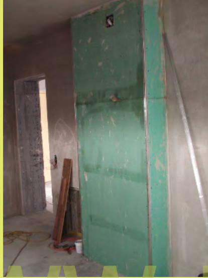
07_Die Kantenschützer für den Steigschacht
