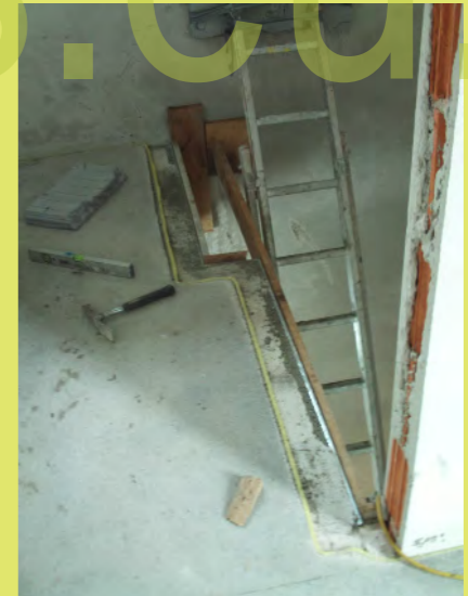
06_Schalung am oberen Treppenauge
