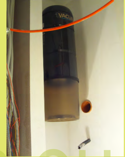
15_ Der Staubsauger ist auch schon montiert
