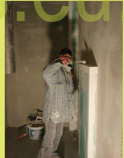
22_Somit passt die Oberfläche zum Putz
