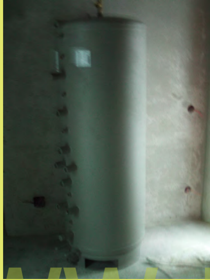
13_ Unser Warmwasserspeicher ist da
