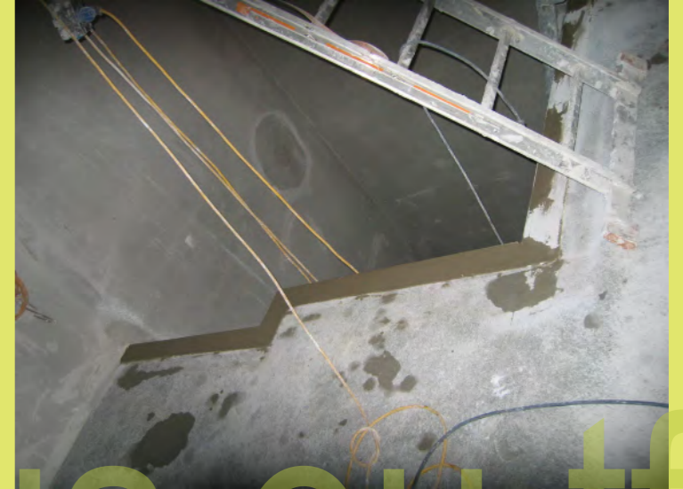
03_Niveauegleich an den Treppenaugen
