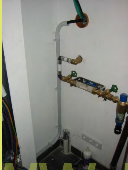
07_Das E-Anschlusskabel wird verlegt
