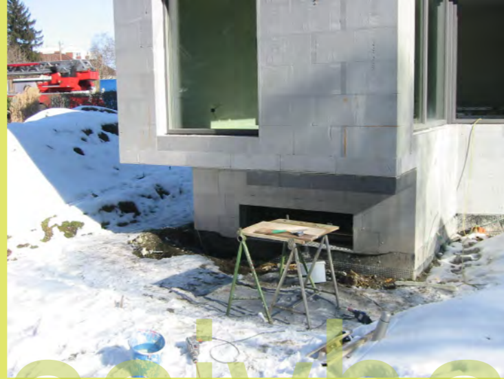
44_So jetzt noch die Untersicht warm einpacken
