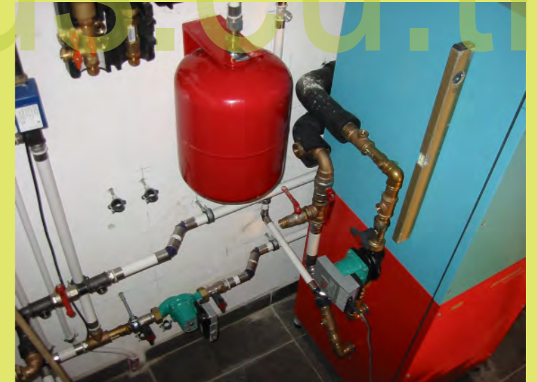
12_Das Kompaktgerät hängt an der Erde
