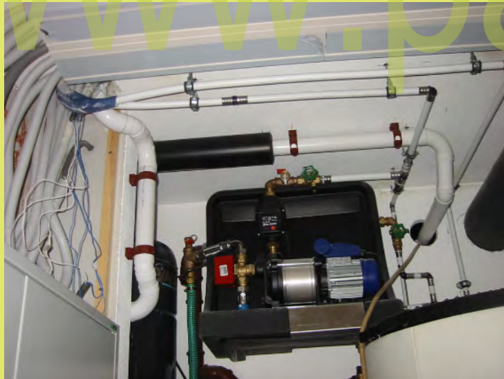
46_Noch mehr Rohre für den Staubsauger
