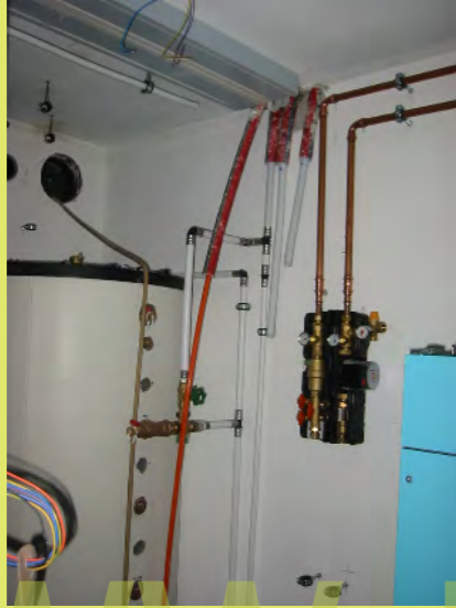
01_Die Verrohrung im Technikraum schreitet voran
