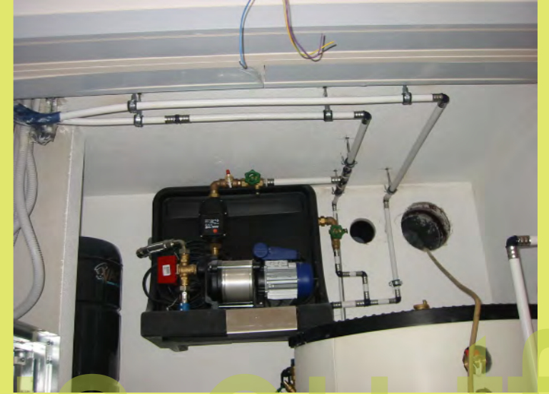
03_Die Regenwasseranlage wird verrohrt
