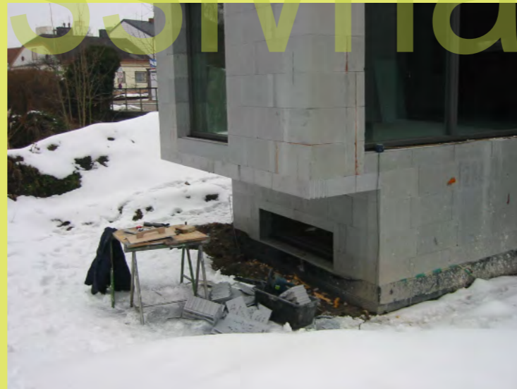
41_Die Randdämmung der Auskragung wird angebr...
