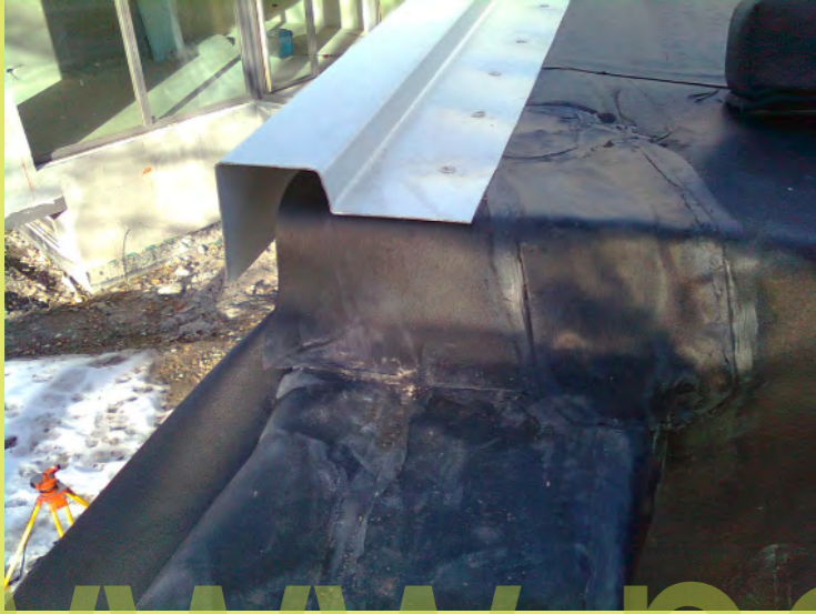
49_Der Folienübergang auf das Garagendach
