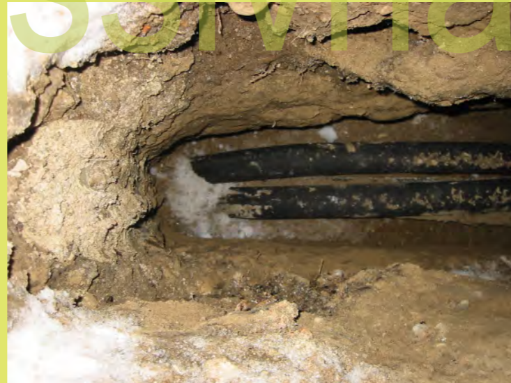
11_Die Tiefenbohrung sit angeschlossen
