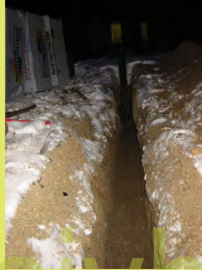
02_Die Künette für die Soleleitung muss vertieft wer...
