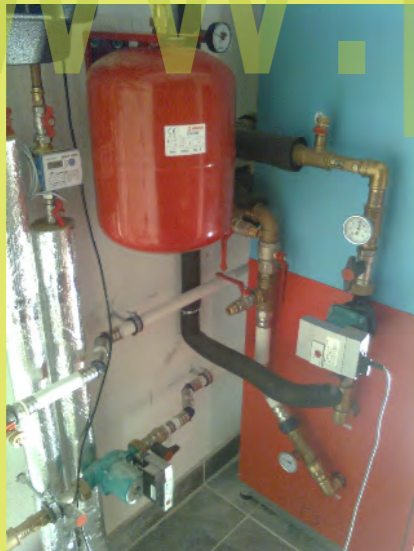
16_Der Solekreislauf ist fertig und gefüllt
