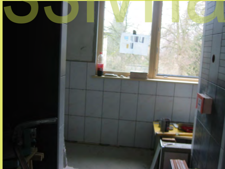
29_Das Fenster im OG-Bad wird umfliest
