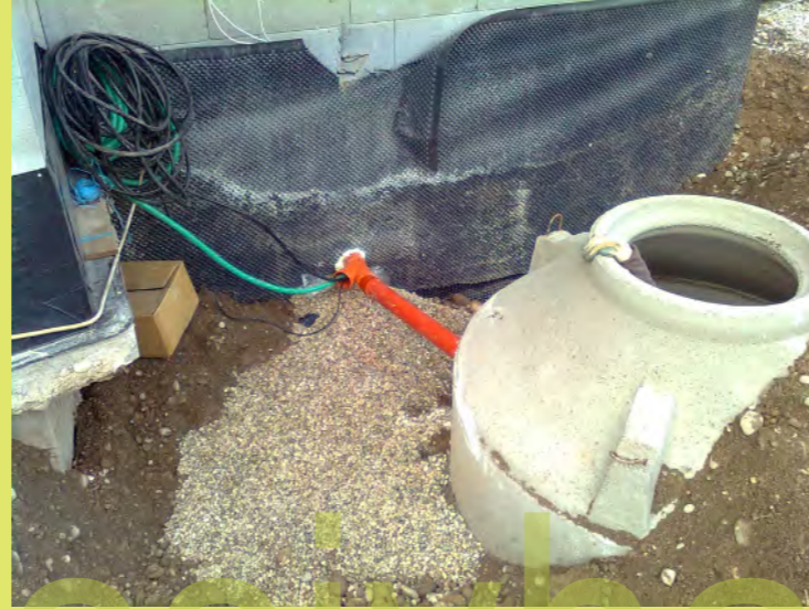
02_Und das Rohr für die E-Leitungen
