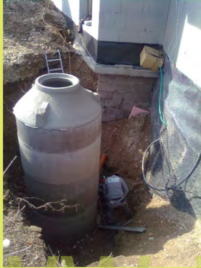
01_Der Schacht für die Hebeanlage
