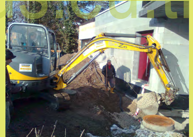
06_Die Leitungen werden mit Kies verfüllt
