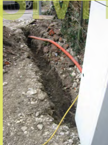
47_Der Graben für die Muffung des Erdkabels
