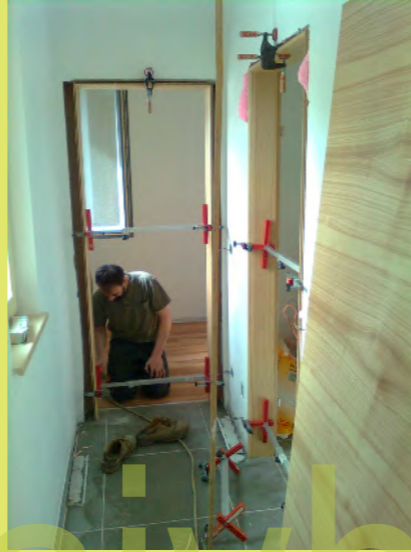
62_Und auch gleich montiert
