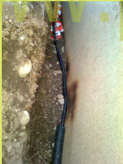
58_Das E-Werk hat das Erdkabel gemufft
