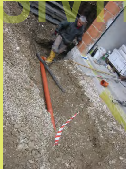
11_Und das Stromkabel muss auch unter die Erde
