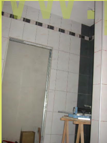
22_ Der Schiebtürkasten ist verkleidet
