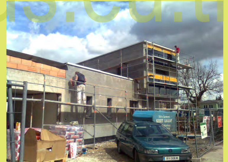
66_Bevor geputzt wird wird geschliffen
