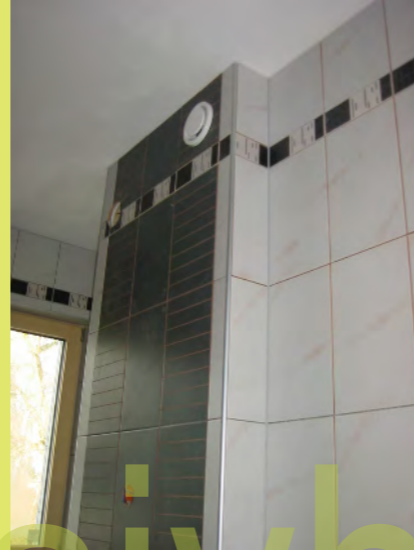
50_Die Luftdüsen werden montiert
