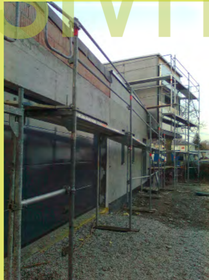
65_Rundherum ist eingerüstet
