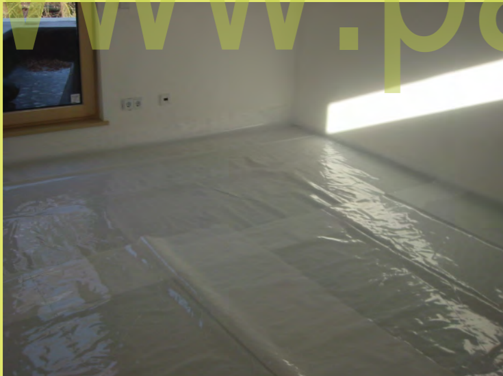
34_Der Bodenleger verlegt die Dampfbremse
