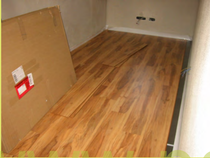
37_Raum für Raum wird fertig
