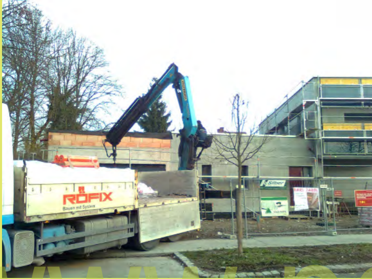
67_Das Putzmaterial wird angeliefert
