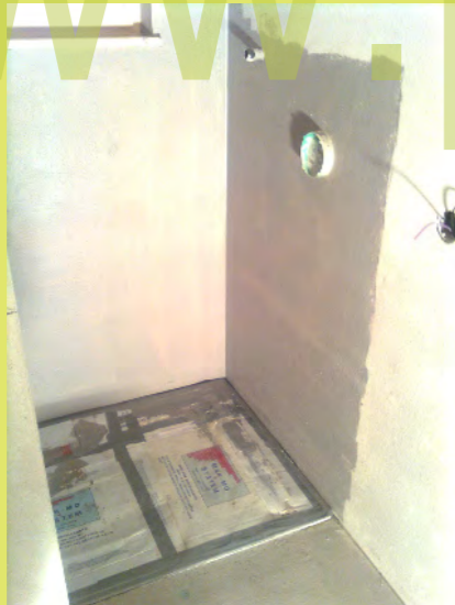
16_Dichtanstrich für die Dusche
