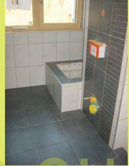
39_Im Bad ist der Fliesenboden gelegt
