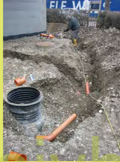
08_Die Regenrohre werden am Tank angeschlossen
