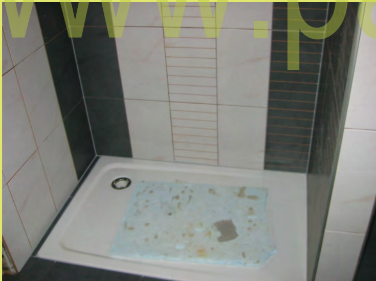
52_Das Bad im OG ist fertig
