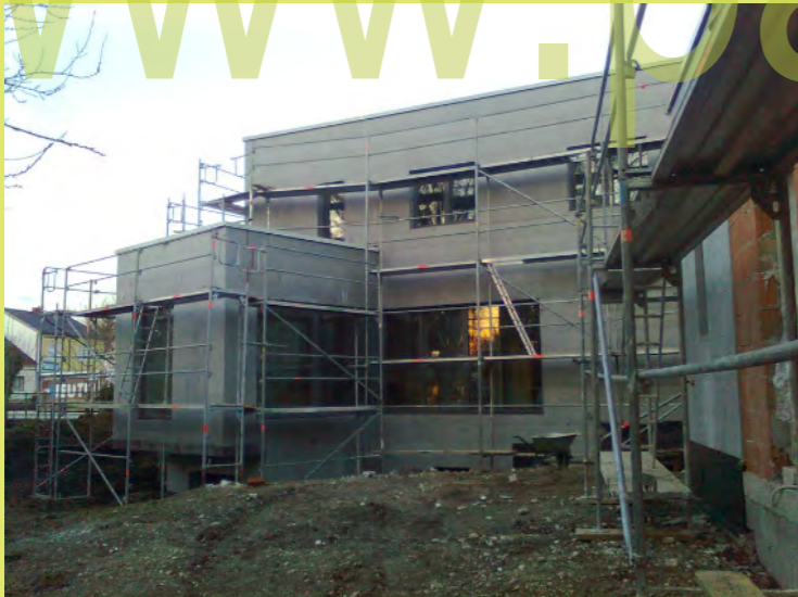
64_Aussen gehts mit dem Gerüstaufbau weiter
