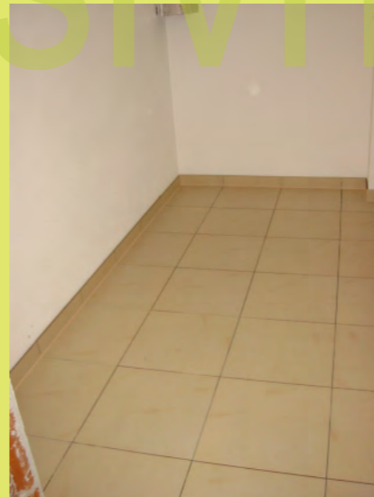
53_Auch in der Waschküche gibts einen Fliesenboden
