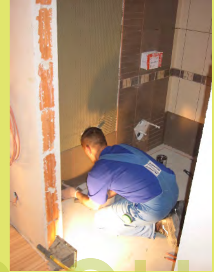
45_Fliesenfinale im Keller-Bad
