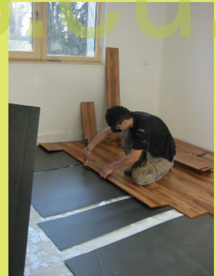
42_Trittschalldämmung und Element für Element
