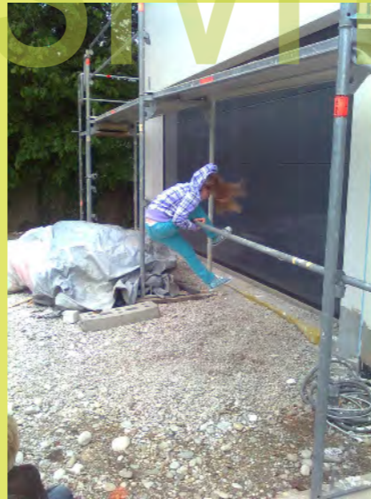
11_Und Vanessa nutzt das Gerüst als Turngerät
