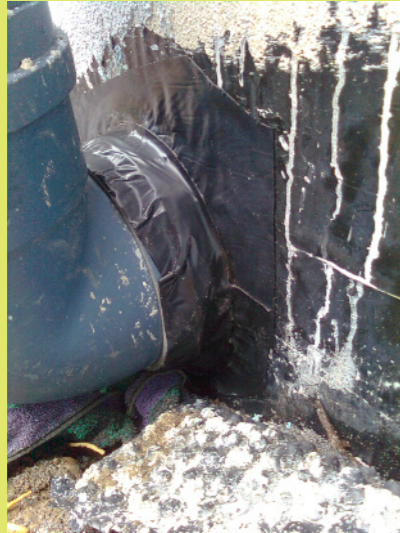
01_Das Zuluftrohr wird abgedichtet
