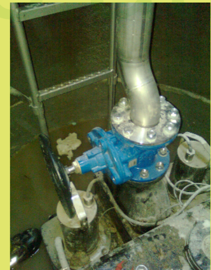
06_Im Hebeschacht wird die Pumpe verrohrt
