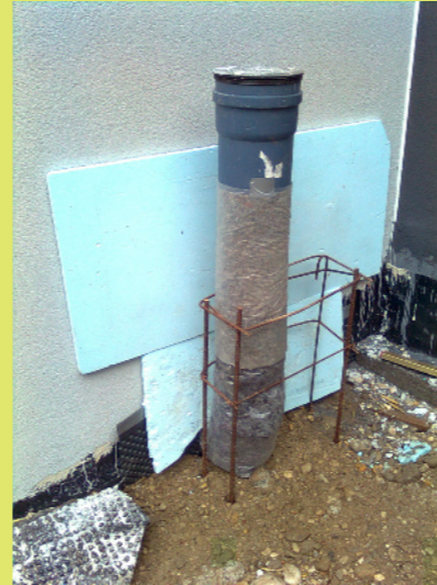
02_Bewehrung für das Fundament
