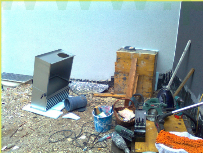
04_Der Luftansaugkasten wird vorbereitet
