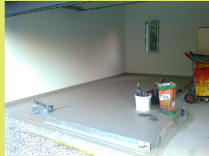
09_Damit mit dem Verfliesen begonnen werden kann
