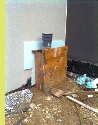
03_Schalung fertig zum betonieren
