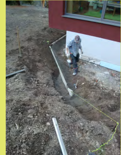
09_Die Böschung mit vielen Winkeln
