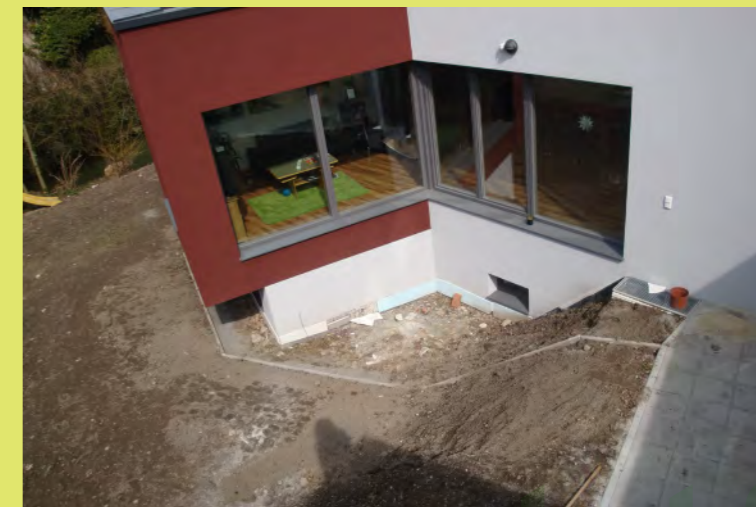
15_Fertig für die Schotterung
