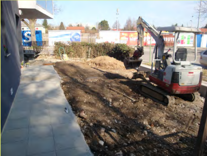
07_Der Bagger verteilt den vorhandenen Humus
