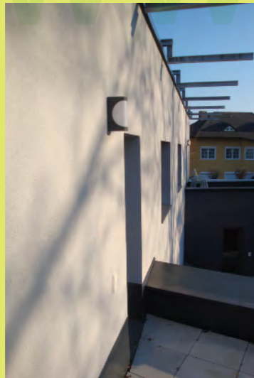
04_Die Aussenbeleuchtung wird montiert
