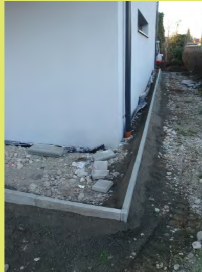
08_Die Leistensteine werden in Trockenbeton gesetzt
