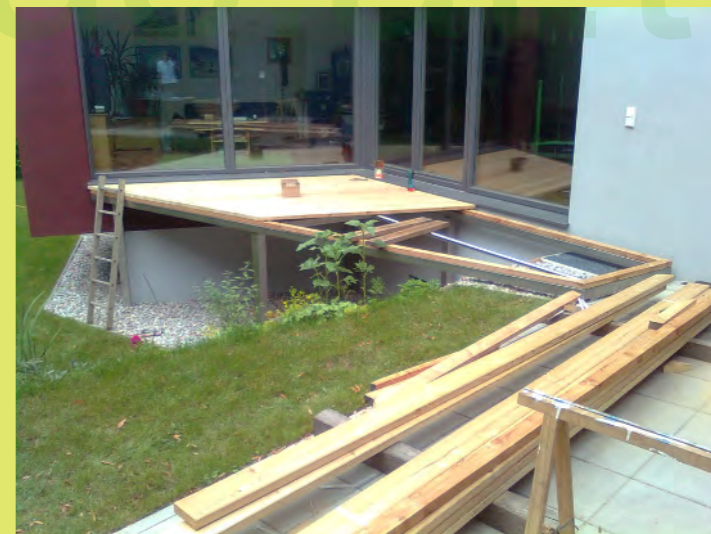
12_Dann werden die Lärchenpfosten montiert
