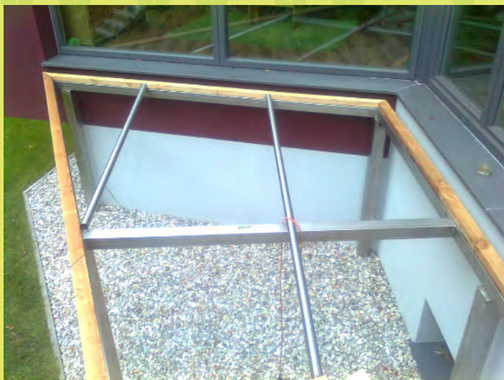
10_Zuerst die Lärchen Unterkonstruktion
